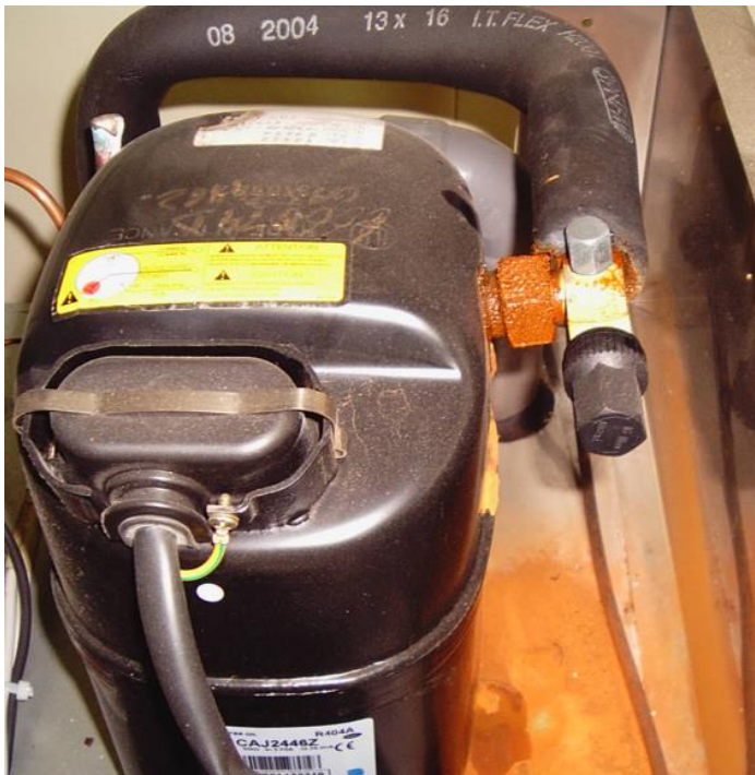
Rez a poměření ocelových částí kompresoru znamená vysokou vlhkost v okruhu.
